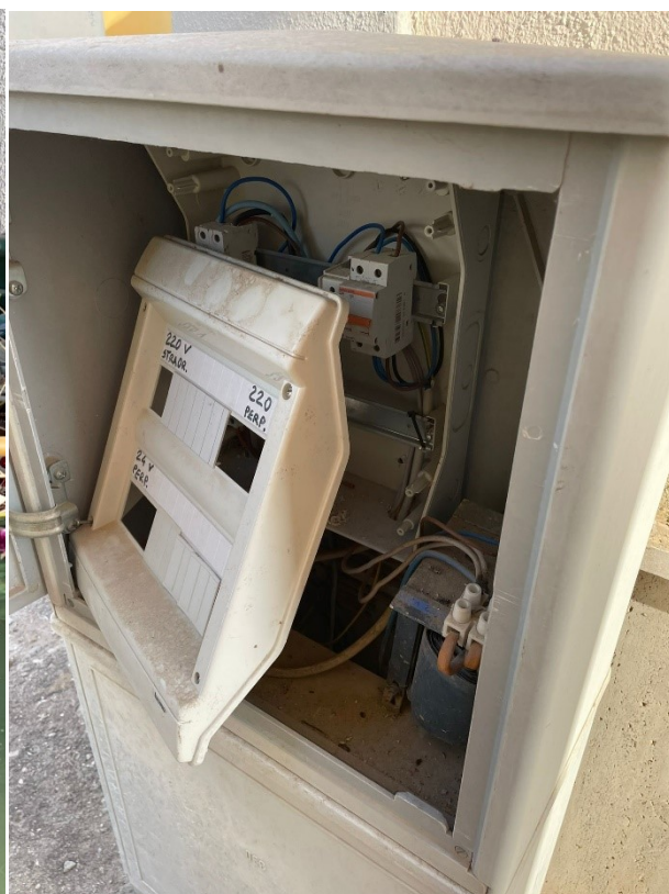
Quadri completamente aperti ad elevatissimo rischio di contatto diretto
