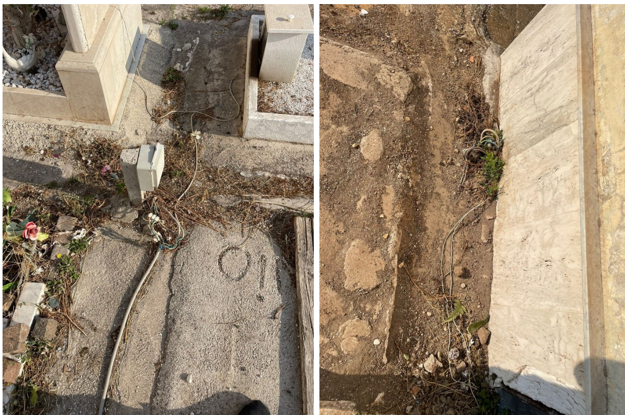
Cavi volanti posizionati a terra senza alcuna protezione e giunti con nastro isolante
