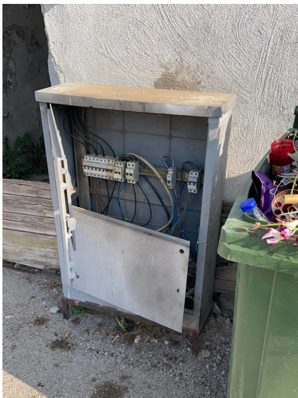
Quadri completamente aperti ad elevatissimo rischio di contatto diretto
